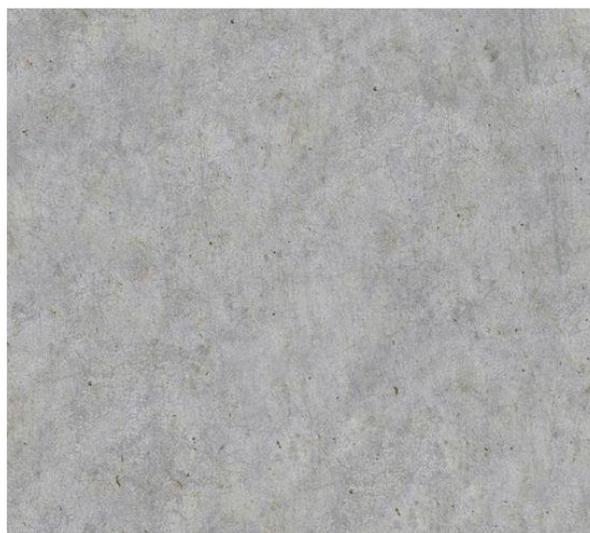
*Figura 6 - Piso em Concreto Desempenado*
