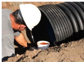
Figura 38 - Aplicação da pasta lubrificante
