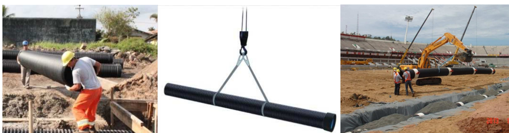
Figura 37 - Descarregamento e movimentação manual e com cintas de nylon
