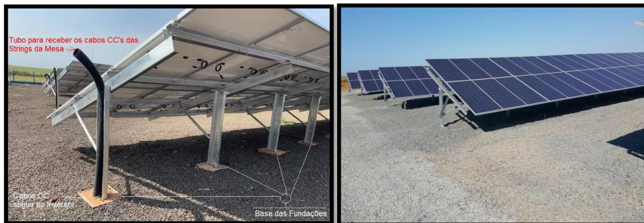
Figura 3 – Exemplo de Estrutura de Fixação (tipo solo)
